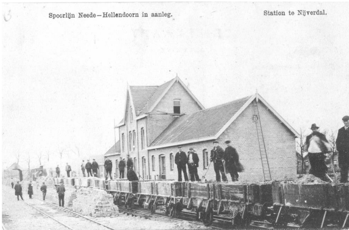
Aanleg van het spoor Neede-Hellendoorn
